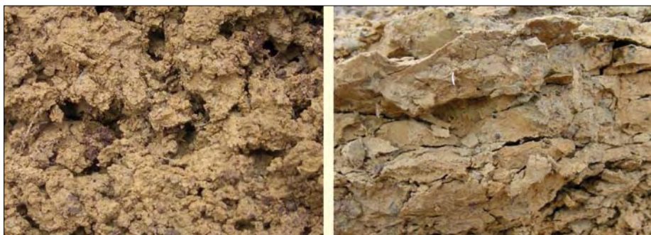
Abb. 2: Unterschiede der Gefügestruktur in nicht verformten und verformten Bodenbereichen. Links: unbefahren – Krümelgefüge, rechts: befahren – plattiges Gefüge
